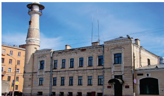
Охтинская пожарная каланча, Большеохтинский пр., д.3
