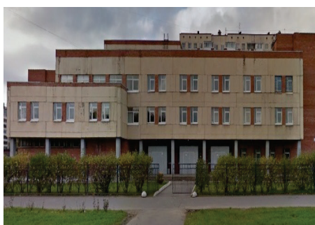
Здание детской поликлиники №69 ул. Коммуны
